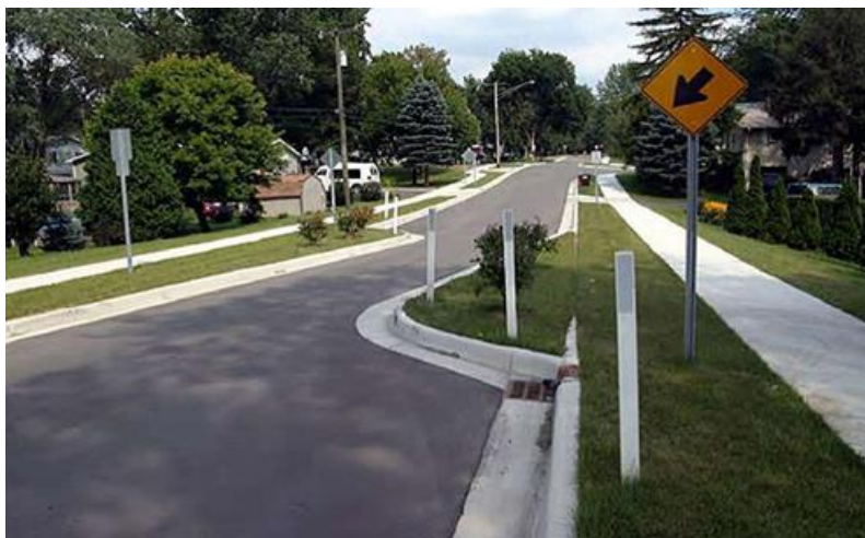
Εικόνα 3. Μεταβολή (θλάση) άξονα οδού
