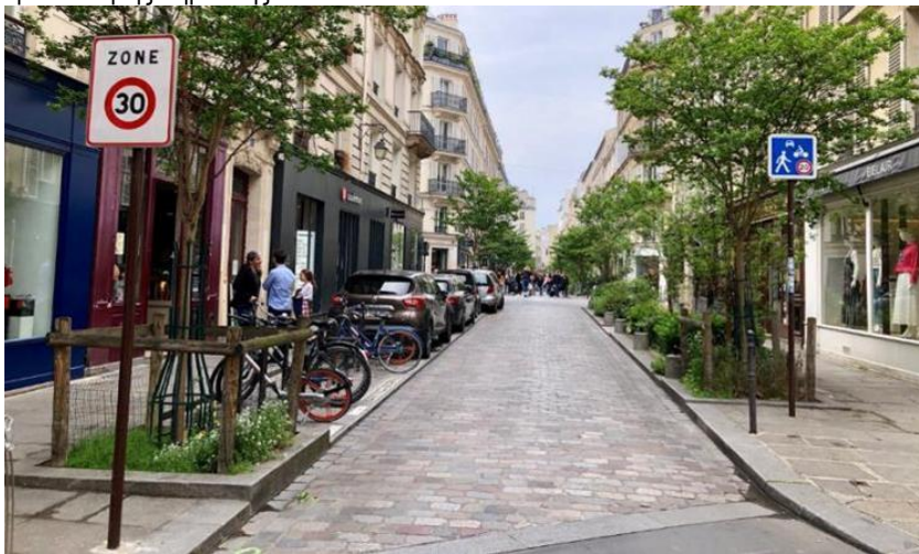
Εικόνα 2. Μετατροπή οδού σε οδό ήπιας κυκλοφορίας
